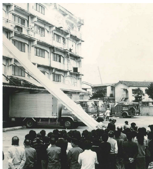
消防訓練の様子 1Fは物流トラックヤードだったことがわかる
